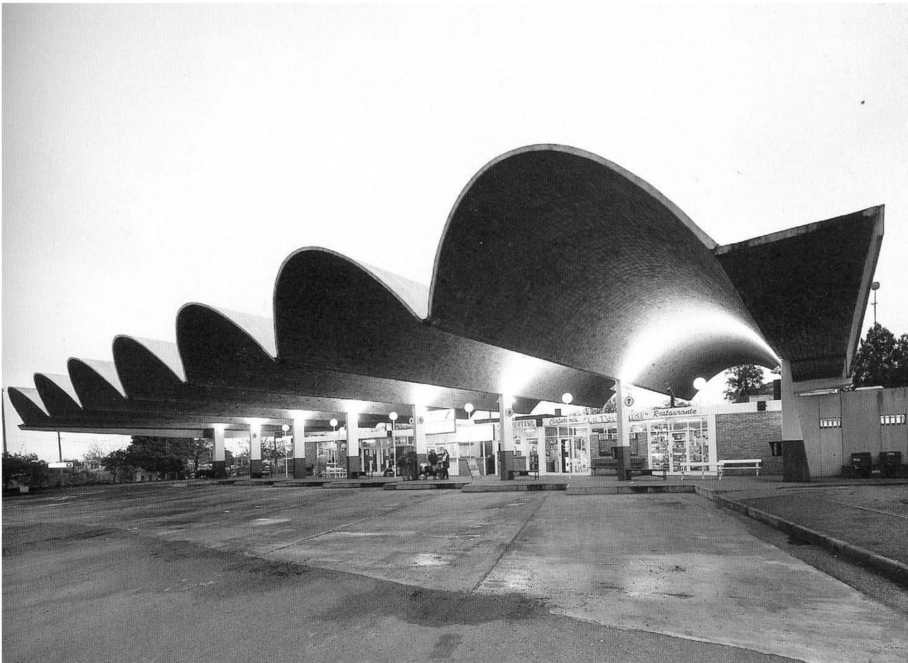
Figura1.- Bóvedas Autoportantes en la Terminal de ómnibus en Salto (Uruguay).
