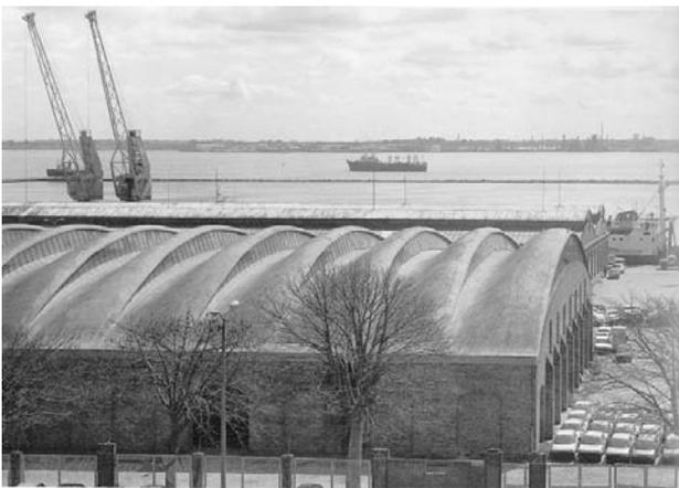
Figura 6.- Vista exterior de las cubiertas Gausas en Montevideo.
