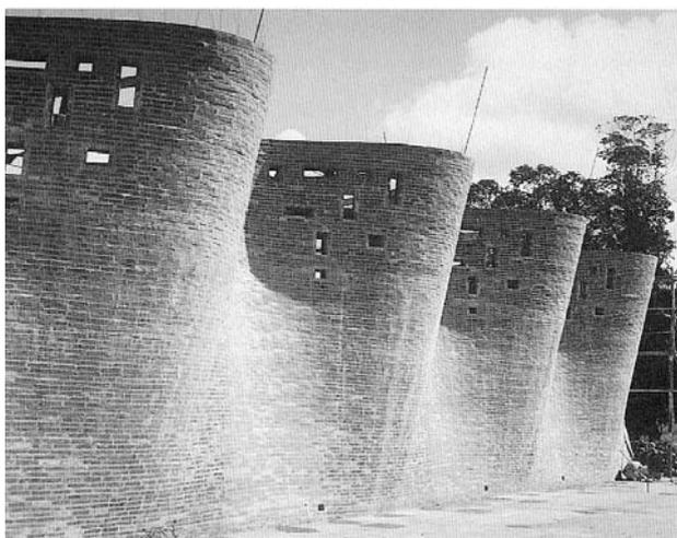
Figura 10.- Terminación de las paredes onduladas con las barras en espera para los tirantes de la cubierta.
