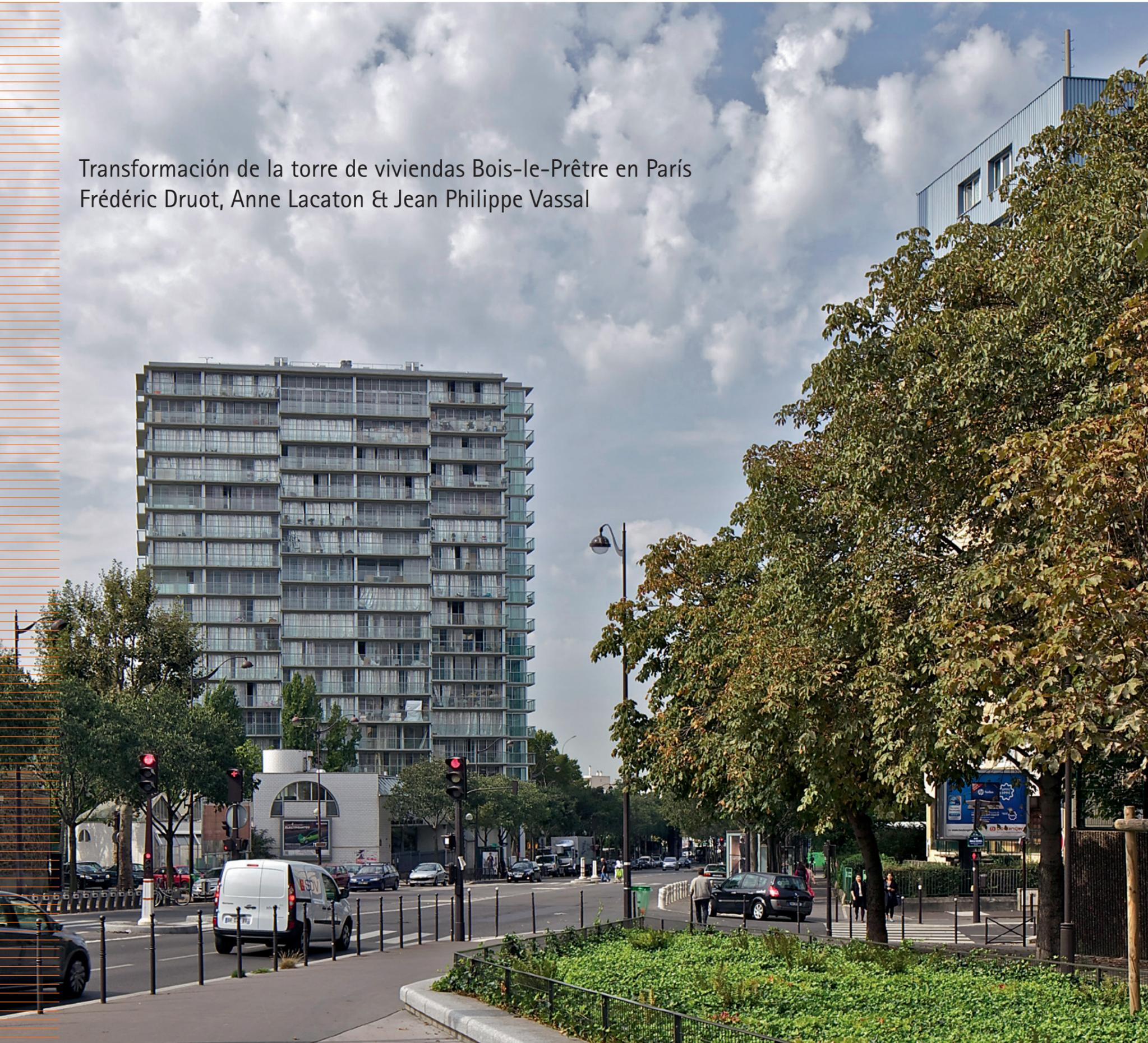
A través de una serie de módulos prefabricados, estructuralmente independientes, que se van apilando en altura, y de una envolvente bioclimática de cerramientos móviles, Druot y Lacaton & Vassal consiguen dotar a las viviendas de la torre Bois-le-Prêtre en París de superficie suplementaria y mayor luminosidad, además de renovar por completo su imagen urbana. La torre se ha convertido en un referente para la regeneración de la vivienda social construida en la segunda mitad del pasado siglo.
