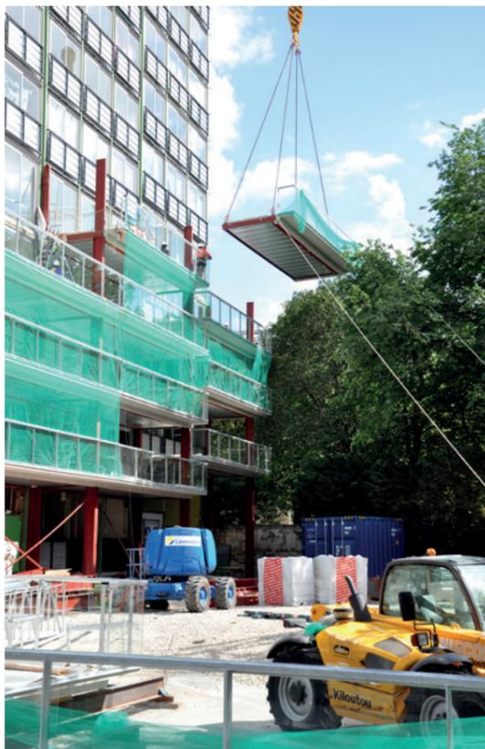
Imagen de la construcción del sistema, con el montaje de la plataforma de hormigón. Debajo, sección transversal del proyecto, con la repetición de módulos añadidos por delante de la fachada original.
