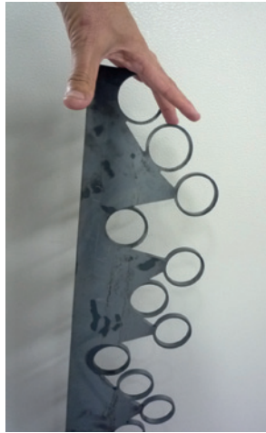
Detalle de fijación de los tubos de policarbonato en fachada. A. Chapa de acero inoxidable e=10\text{ mm} cortada con láser y pintada al esmalte. B. Patilla anclada a muro con tornillos autorroscantes. C. Tubos de policarbonato \varnothing 55\text{ mm} de distintos tonos y superficie interior estriada. D. Cilindro de policarbonato macizo para conexión de tubos.
