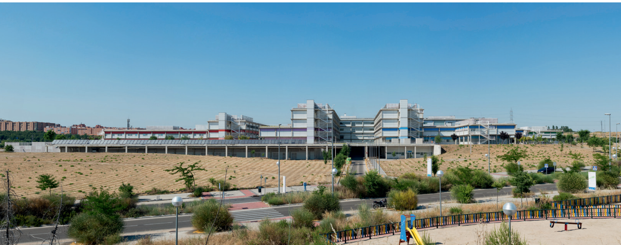
Vista general desde el sur, con la central energética porticada y el acceso de servicios en el eje del edificio a nivel del semisótano.
