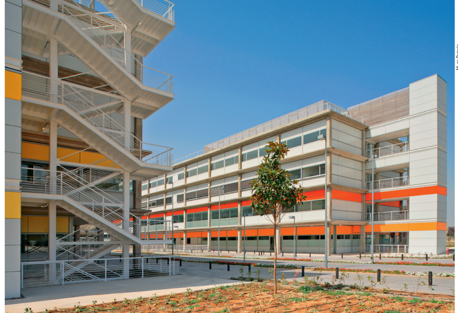
Algunos de los elementos fundamentales de la estrategia de resistencia al fuego del edificio: las torres de emergencia en los extremos de os pabellones, los núcleos verticales interiores formando exclusas y la ménsula perimetral que actúa como barrera entre plantas. A la derecha, croquis inicial de la fachada.
