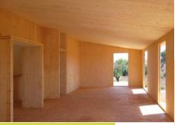
Los paneles de CLT se pueden utilizar para la construcción de parades, forjados y cubiertas.
