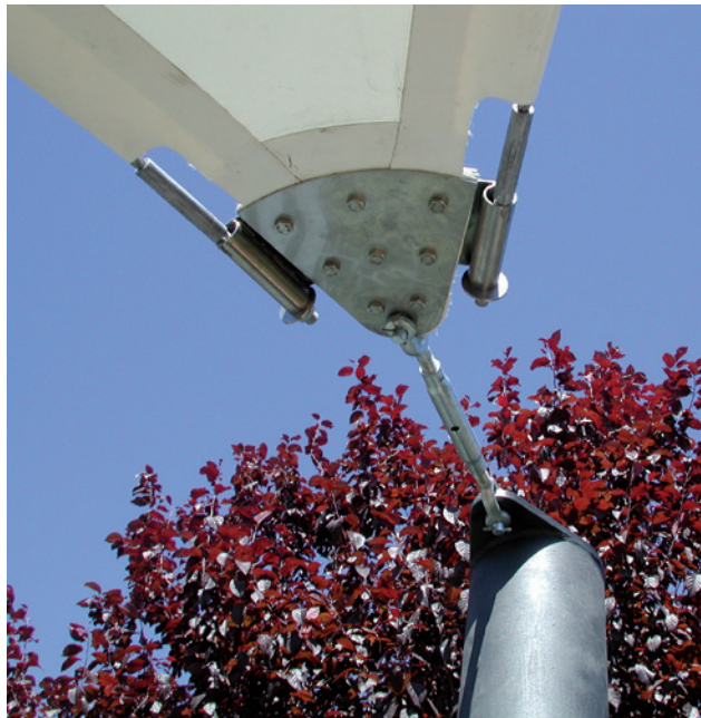
A la izquierda, detalle de la placa y refuerzo en el vértice de una cubierta textil con cable de borde interior.
