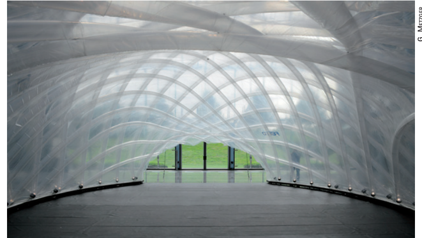
Pabellón Plusminus, estructura en malla de vigas neumáticas estabilizadas por doble lámina formando una cámara en subpresión. Studio LTA, 2010.
