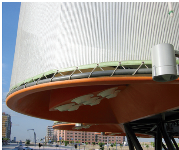
Imágenes de la fijación de la membrana en el Ecobulevar de Vallecas, Madrid (D. García-Setién, B. Tato, J.L. Vallejo, 2005). Arriba, solución inicial, con borde acordonado que producía cargas puntuales y falta de pretensado con riesgo de
