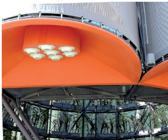
Imágenes de la fijación de la membrana en el Ecobulevar de Vallecas, Madrid (D. García-Setién, B. Tato, J.L. Vallejo, 2005). Arriba, solución inicial, con borde acordonado que producía cargas puntuales y falta de pretensado con riesgo de
