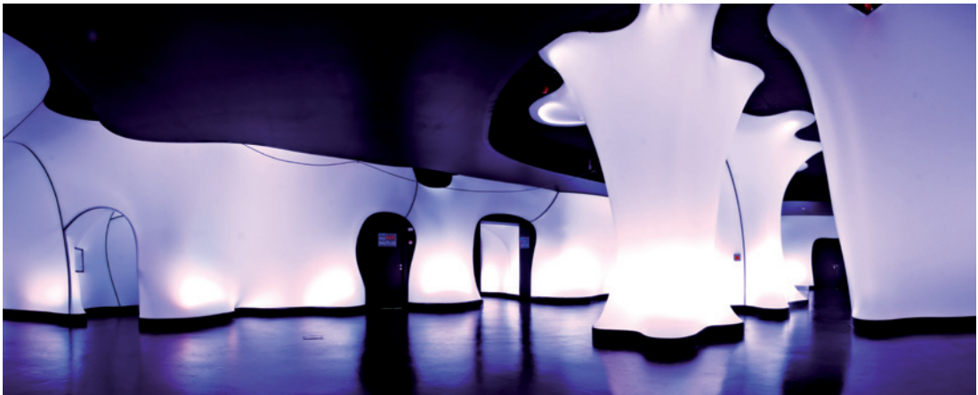
Paramentos de lámina de PVC tensada con calor y retroiluminada. Aquarium Finisterrae. J. M. López Mihura, 2010. Por su elevada elasticidad, las láminas de PVC no son apropiadas para aplicaciones exteriores.
