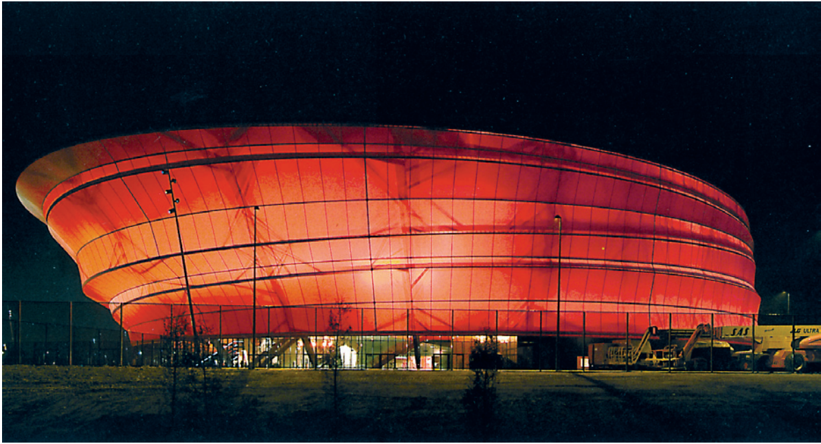
El auditorio Zénith en Estrasburgo se envuelve con una piel de fibra de vidrio y silicona elegida por su comportamiento con la luz. M. y D. Fuksas, 2007.
