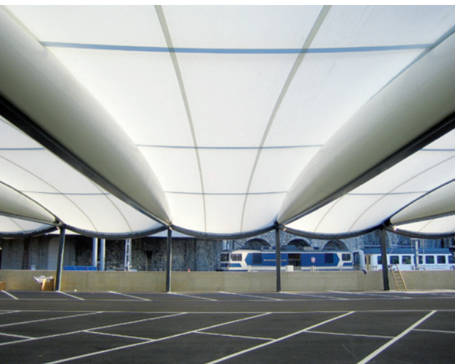
Cubierta textil Tensairity formada por vigas neumáticas y membrana tensada entre ellas.
