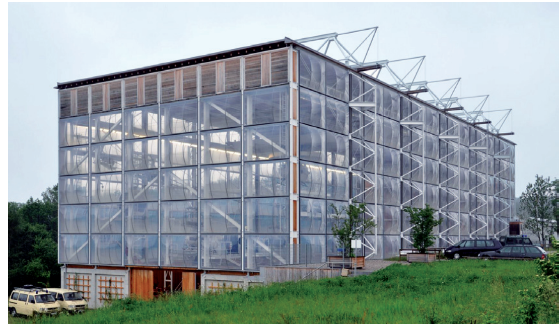
Cerramiento ligero y transparente de ETFE. Centro de entrenamiento forestal, Bad Tölz, Alemania. Herzog + Partner, 2008.
