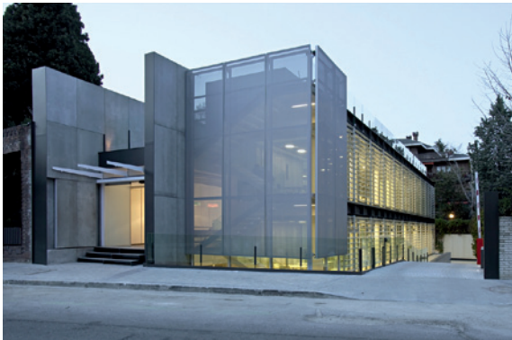
Fachada textil realizada con malla microperforada de poliéster y PVC. Sede de las oficinas de Eneres en Madrid. Luis de Pereda, 2010.
