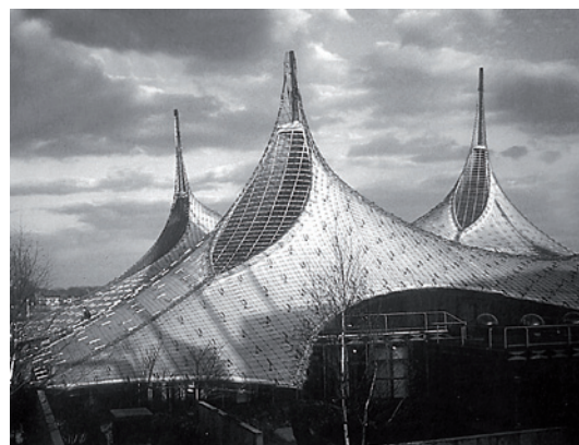
Dos ejemplos de cubierta sustentada sobre malla de acero. A la izquierda, pabellón en Nizhny Novgorod, Rusia. Vladimir Shukhov, 1896. A la derecha, Pabellón de Alemania en la Expo de Montreal 67. Frei Otto.
