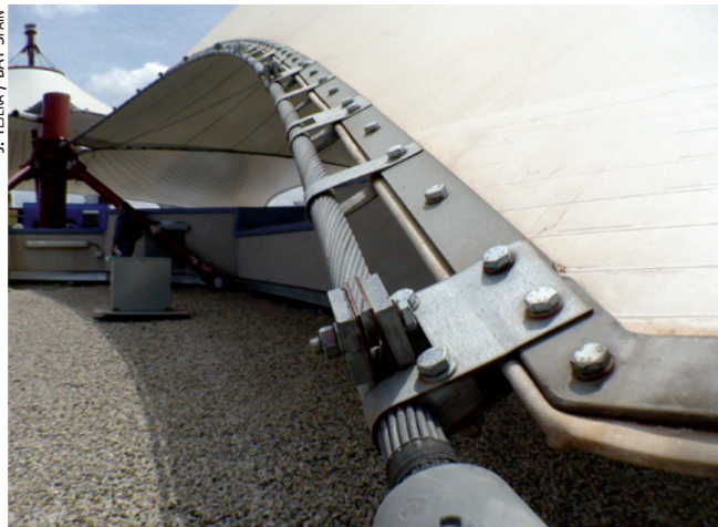
A la izquierda, detalle de la placa y refuerzo en el vértice de una cubierta textil con cable de borde interior.
