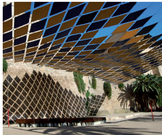
Cubierta tensostática realizada con estructura de red de cables y malla textil. Baluarte de ses Voltes, Palma de Mallorca. E. Torres y J. A. Martínez Lapeña, 2000. Vivienda en Santiago de Chile protegida con envolvente de tejido polimérico que incorpora bandas de aluminio. Frohn Et Rojas, 2007.
