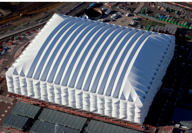
Envolvente constituida por una membrana de poliéster recubierto con PVC. Basketball Arena, Londres. Wilkinson Eyre, 2011.
