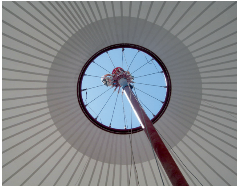
Detalle del anillo en el punto alto de una cubierta cónica.
