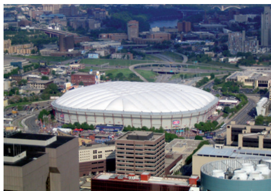
Arriba, cubierta presostática realizada con membrana simple reforzada con cables y estabilizada por presión. Metrodome, Minneapolis. SOM y Geiger, 1982.
