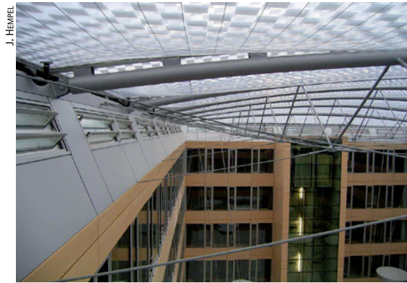
A la izquierda, sistema de sombreado variable en cojines de ETFE. Abajo, patio cubierto con cojines formados por tres láminas de ETFE con sistema de sombreado variable. Ampliación de edificio administrativo en Ludwigsburg, Alemania. Kubeneck Architekten, 2007.
