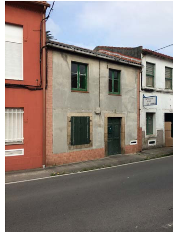
[Vista 01] Fachada principal
