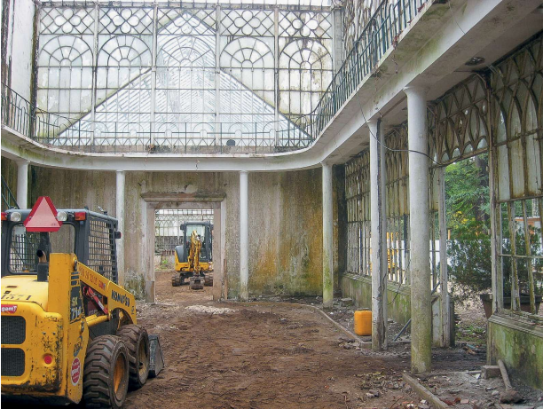
4. Imagem tirada durante a demolição da galeria em betão armado do corpo central das Estufas do Jardim Botânico.
