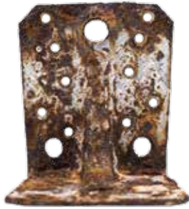
Conector de acero pregalvanizado Z275 Gran parte del conector está completamente oxidado.
