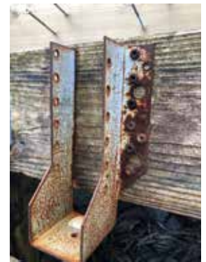
Estribo pregalvanizado en abril de 2022
