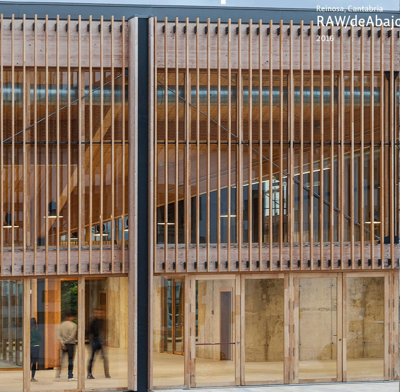
IMPLUVIUM es una gran cubierta con estructura de madera laminada compuesta por piezas cortadas en taller y ensambladas en obra sobre los restos de un antiguo mercado, demolido tras un incendio. La cubierta, junto con las cuatro cajas de servicio que emergen del suelo, conforman la infraestructura necesaria que permite que se produzcan múltiples eventos, tanto de manera espontánea como programada, bajo un mismo techo.
